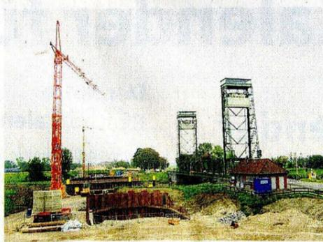
Bau einer neuen Klappbrücke, sie soll die 1951 erbaute Hubbrücke ersetzen. GJ-FOTO: JAUKEN
