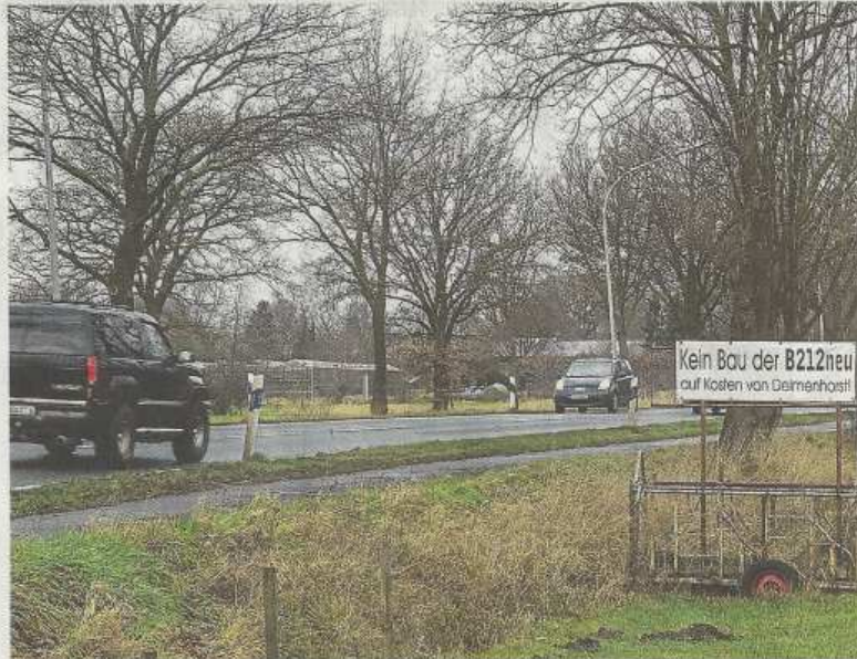
„Kein Bau auf Kosten von Delmenhorst“: Zur B212neu gibt es viele Positionen. Um die Planung der Bundesstraße hat die FDP eine heiße Diskussion ausgelöst.
